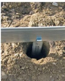
► Erdanker werden verwendet, falls die Wellenprofilierung für Standfestigkeit im Boden nicht ausreicht. Der Einbau in Kies, Schotter, eng gebogene Radien oder Hanglagen sind typische Anwendungsbereiche.
