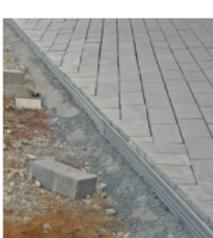
► Alternativ zu Erdankern können beim Einbau der Profile in Kies oder Splitt Betonfundamente gesetzt werden.
