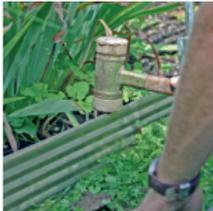
► Zuerst werden die Profile verschraubt, dann in der geplanten Form (gerade oder geschwungen) aufgebaut und mit Fixierstäben in Position gehalten. Die Fixierstäbe haben eine Führungsnase zum Einhaken der Profile. Die Fixierstäbe werden nach dem Einbau entfernt und sind wieder verwendbar.
